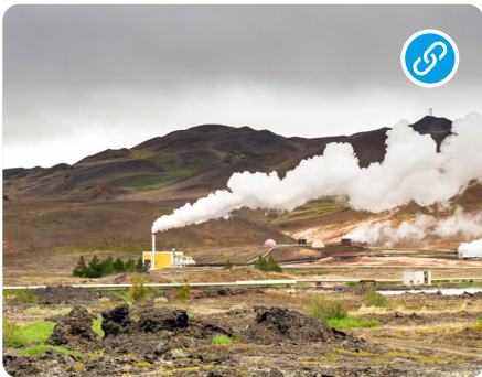
Un nuevo método el CSIC mejora la sostenibilidad en el uso de energía geotérmica para climatizar edificios.
