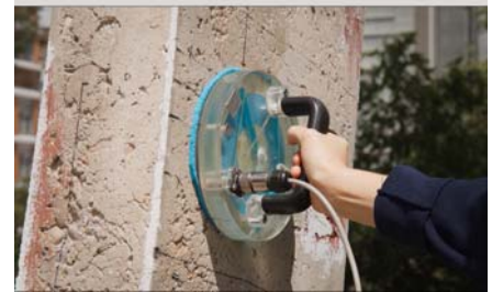
Equipo para la medida de resistividad y velocidad de corrosión (arriba), y ejemplo de implementación in situ sobre una estructura real (abajo).
