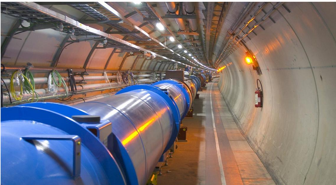
*Con 104 km de tubos en vacío, el Gran Colisionador de Hadrones (LHC) instalado en el CERN posee el sistema de vacío operativo más grande del mundo. / CERN*
