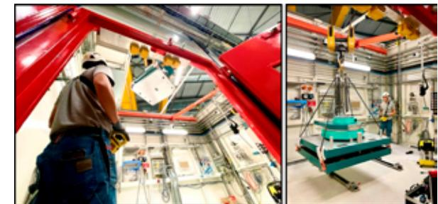
Instalación en SpLine del equipo destinado a la caracterización de cristales únicos mediante difracción de rayos-X.
